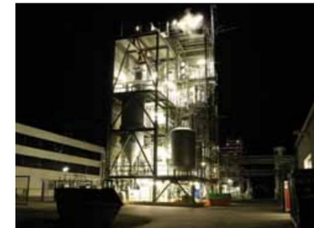
Die Pilotanlage des Schlackebadvergaser am Standort Freiberg wird in enger Kooperation mit dem Institut für Energieverfahrenstechnik und Chemieingenieurwesen der TU Bergakademie Freiberg betrieben. Die Anlage wird für Tests mit verschiedenen festen Kohlenstoffträgern wie z. B. Biomasse und kunststoffhaltigen Abfällen genutzt.
