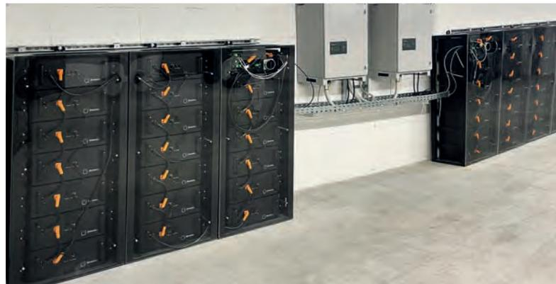
*Batteriespeicher in der Mehrfachnutzung: Zwischenspeicherung von Solarstrom zur Optimierung des Eigenverbrauchs sowie zur Kappung von Lastspitzen.*
